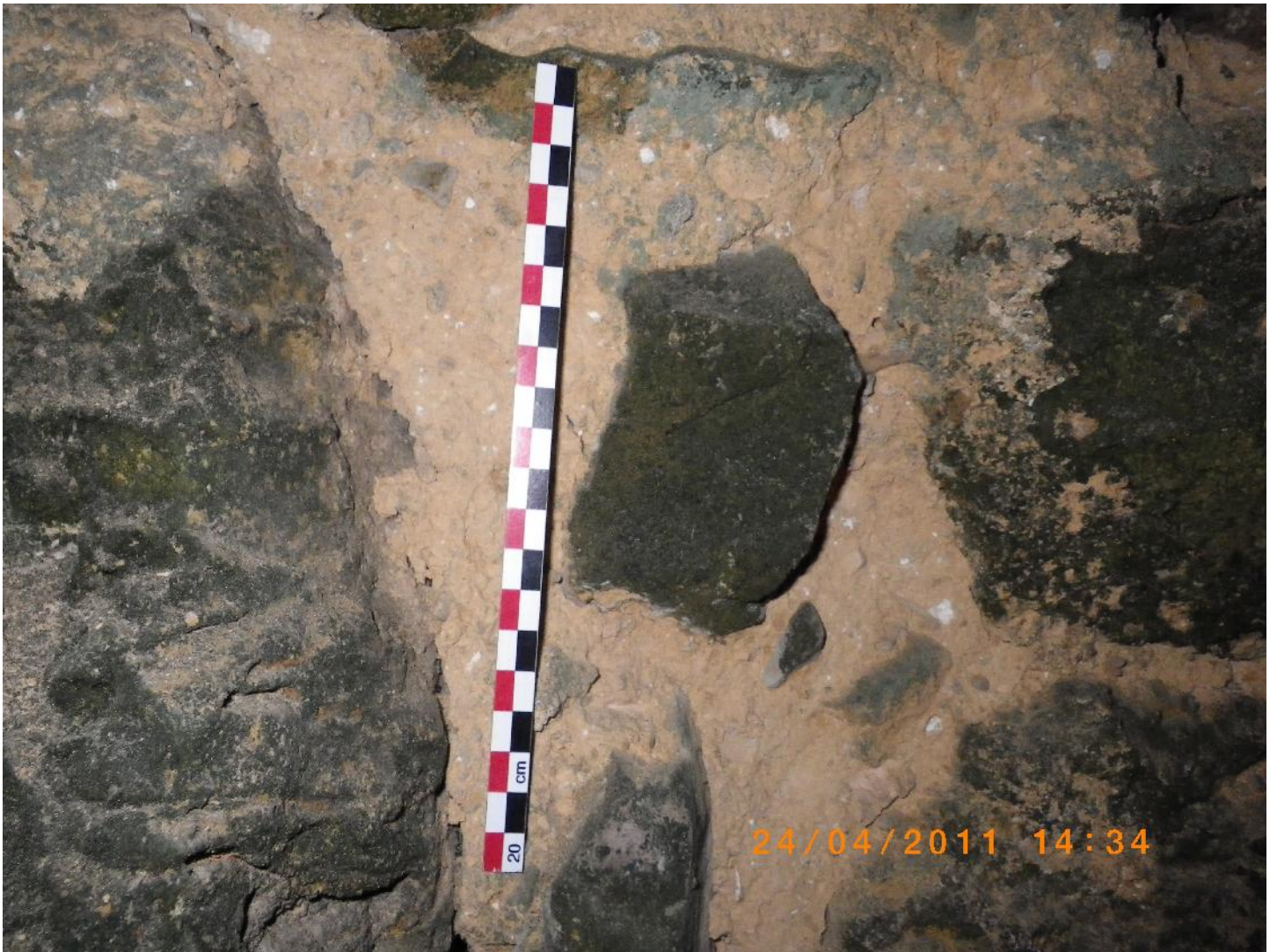
Détail du mur, mortier grossier.
