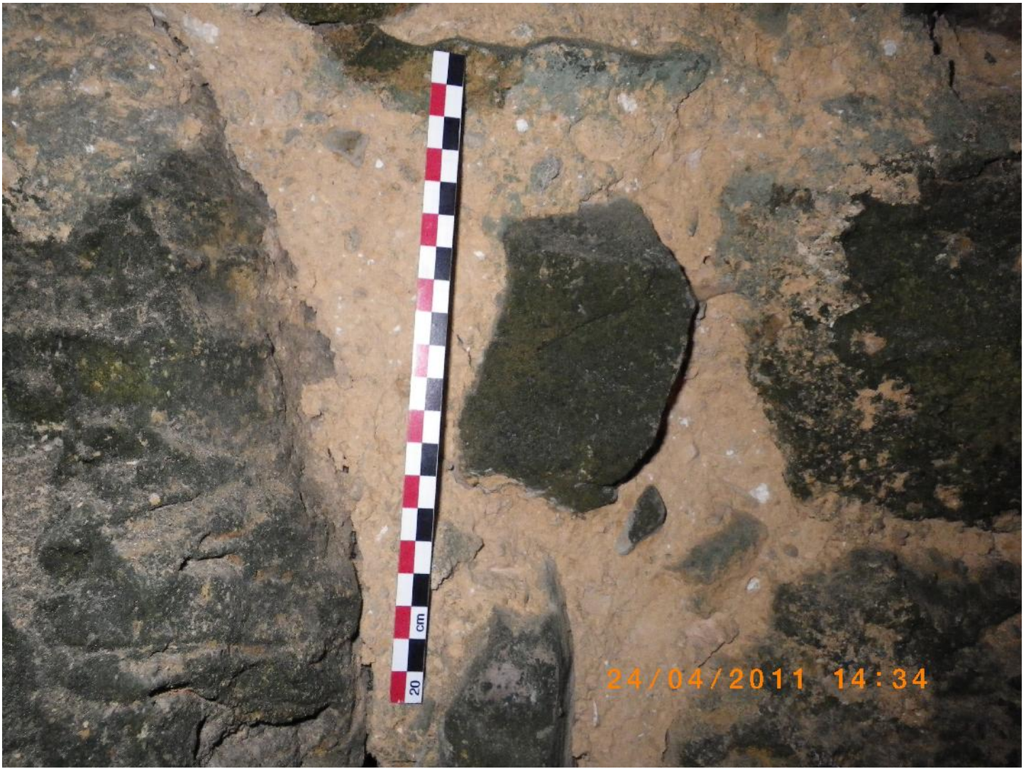
Détail du mur, mortier grossier.
